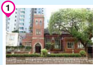
1 九龍佑寧堂 Kowloon Union Church 九龍油麻地佐敦道4號 No. 4 Jordan Road, Yau Ma Tei, Kowloon
